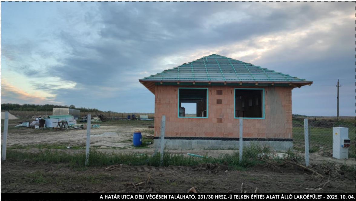
A HATÁR UTCA DÉLI VÉGÉBEN TALÁLHATÓ, 231/30 HRSZ.-Ú TELKEN ÉPÍTÉS ALATT ÁLLÓ LAKÓÉPÜLET - 2025. 10. 04.
